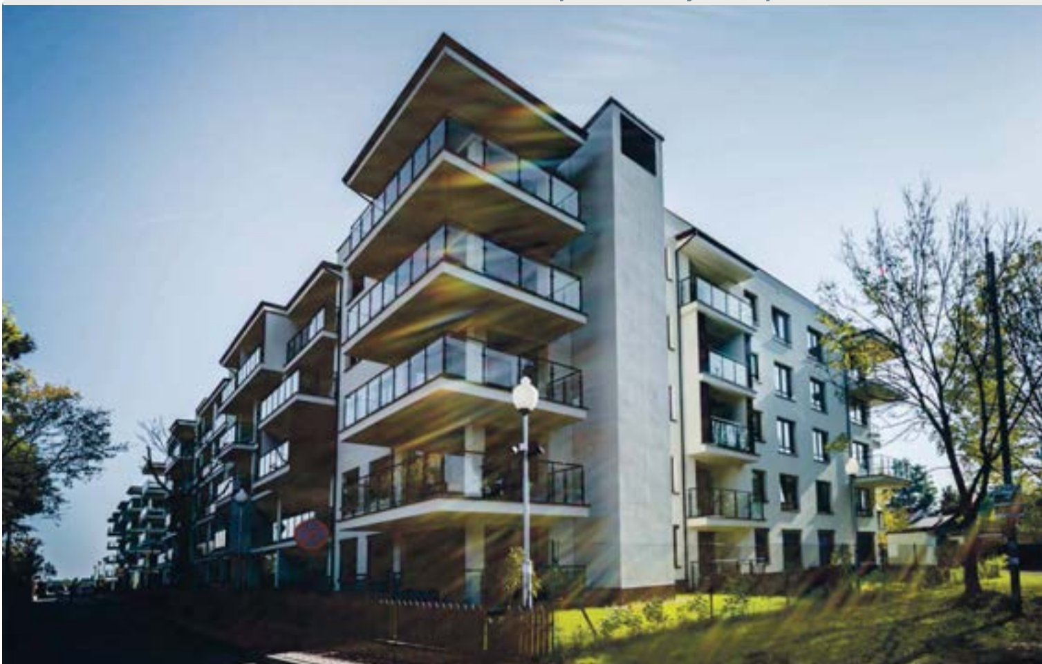
Panorama Krakowska, ul.Fredry 4F/ ul.Fredry 4E, gotowe
